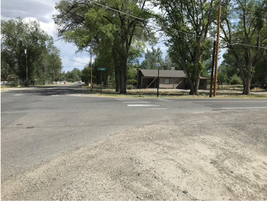
Photo #5 N. E corner 24 & H
