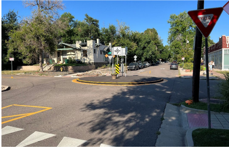
Mini roundabout on a Bicycle Boulevard
