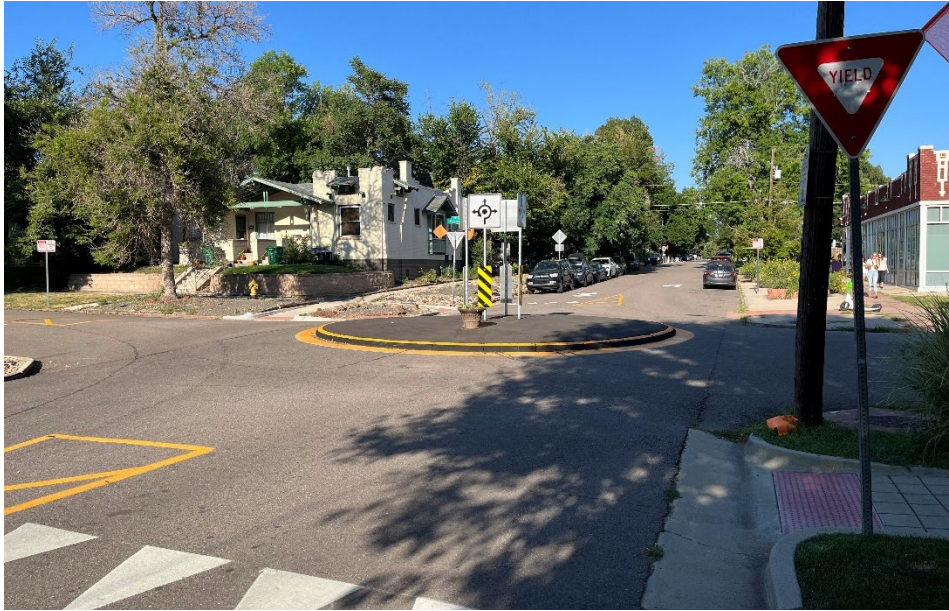
Mini roundabout on a Bicycle Boulevard
