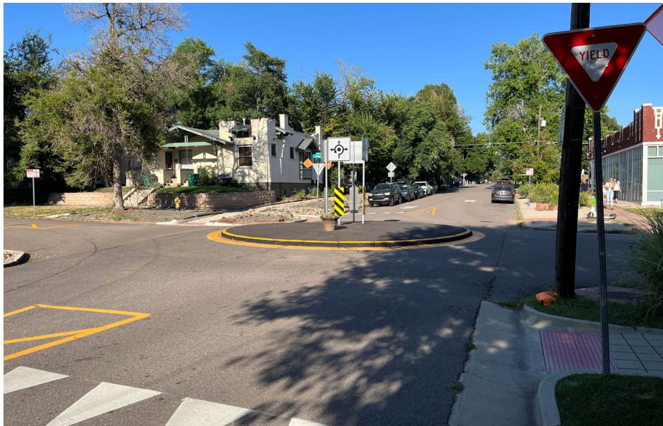
Mini roundabout on a Bicycle Boulevard
