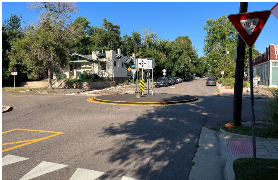
Mini roundabout on a Bicycle Boulevard
