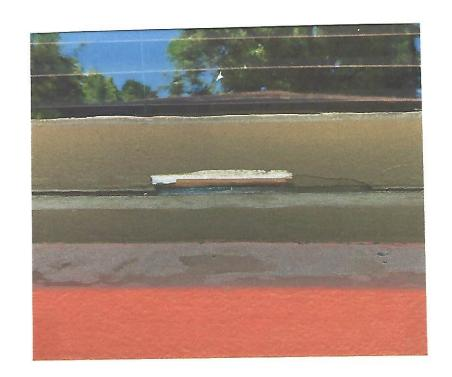
PHYSICAL DAMAGE WHILE ATTEMPTING TO PRY OPEN EXISTING OLD WINDOW,
