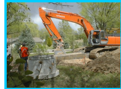
Skvwav Sewer ID
