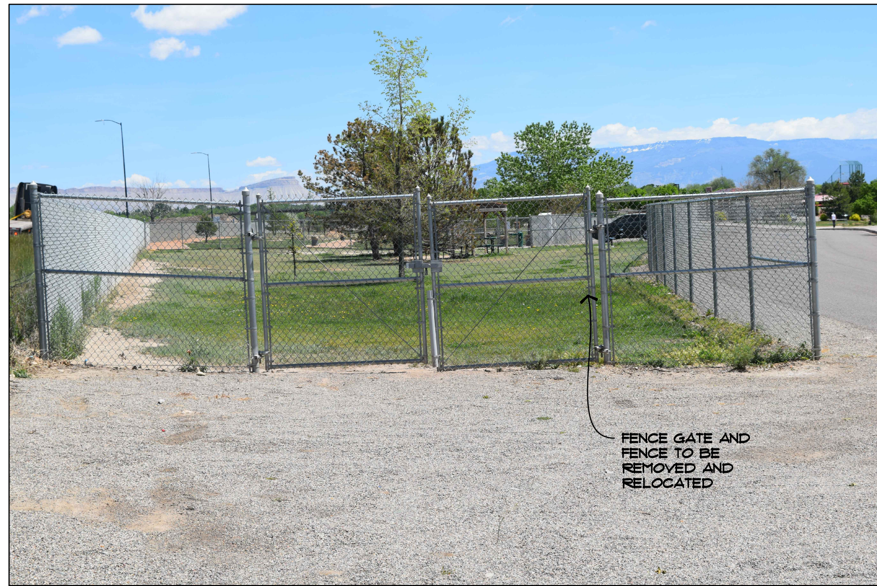
8 SITE PHOTO Z3.0 N.T.S.
