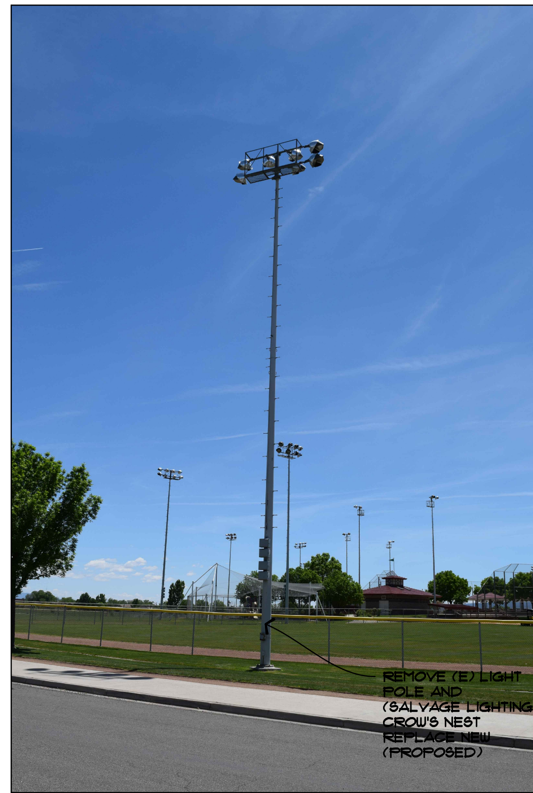
4 SITE PHOTO Z3.0 N.T.S.
