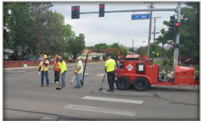
Crack Fill Work
