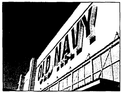
PHOTO SURVEY - EXISTING CHANNEL LETTERS VIEW (2) N.T.S.
